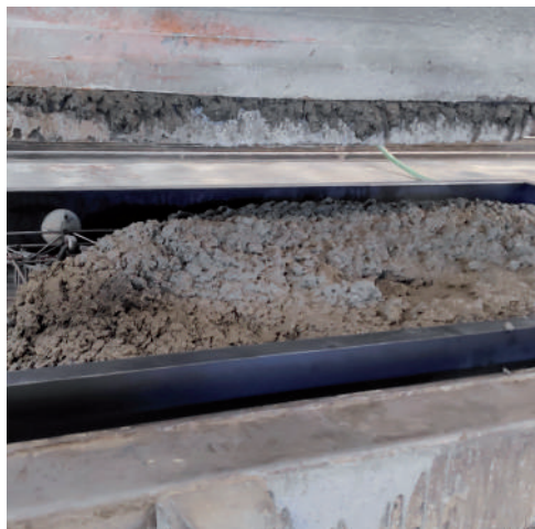
Extensión del hormigón en el molde. Spreading the concrete in the mould.
